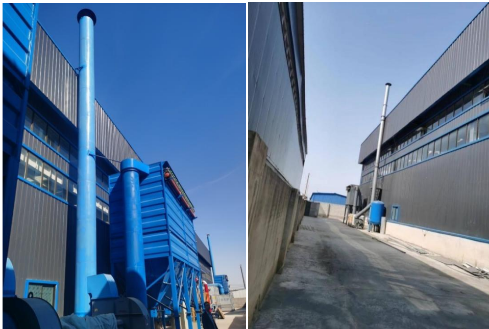
混砂、砂处理废气处理设施及排气筒（DA002）造型废气处理设施及排气筒（DA004）
