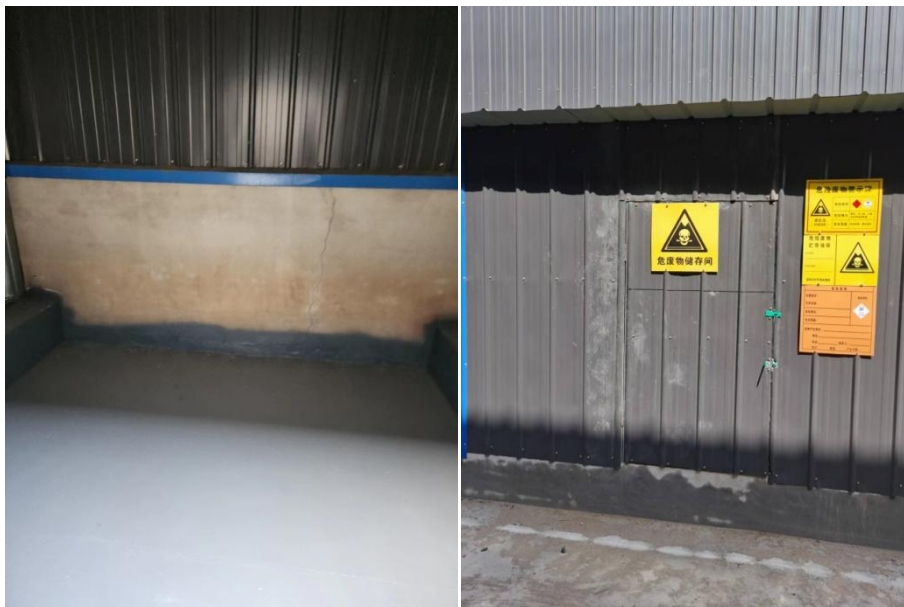
危废暂存间内部及外部
